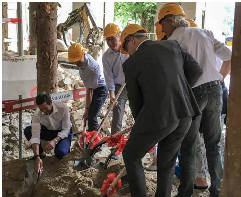
Spatenstich zum Umbau im Juni 2018.
